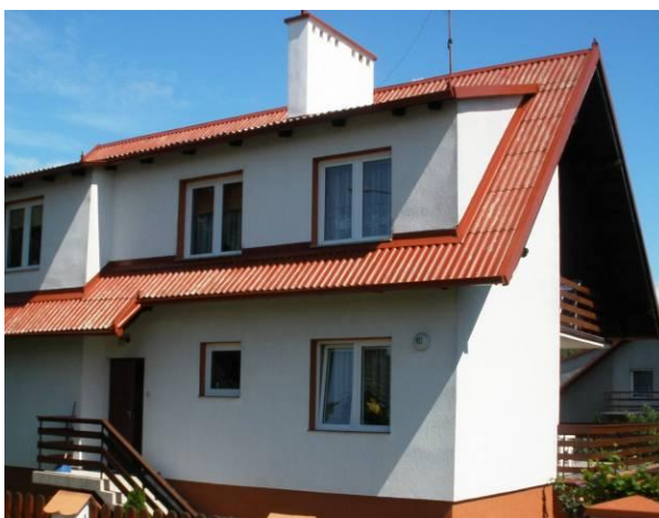
Rys. 5. Przykład zabezpieczenia wykonanego powłoką malarską.
